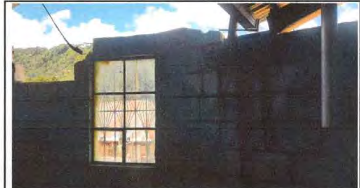
Foto 4: Reparación de muro o pared de la cocina
