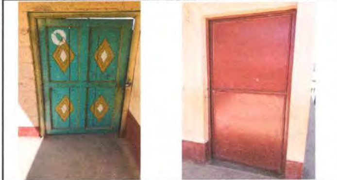
Foto 1: Sustrución de puerta que incluye sustitucion de candado por chapa
