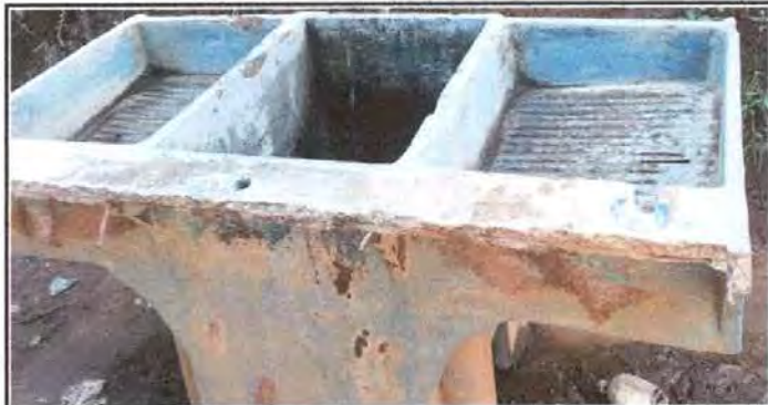
Foto 3: Sustrución de reposadera, caja de registro, red de agua potable llave de chorro y sustitución de pila de cemento de dos lavadero
